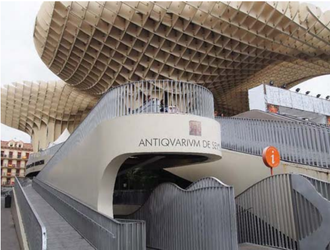
Il. 8. Metropol Parasol, widok od strony południowej (ulicy Imagen), 2018, fot.: J. Białkiewicz
