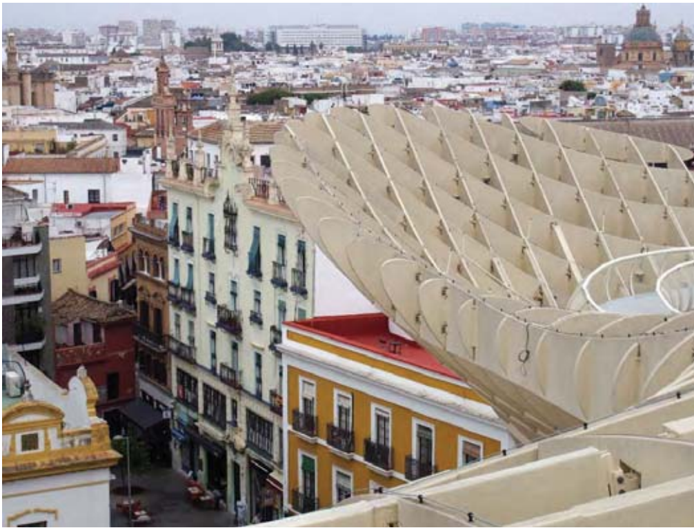
Il. 6. Metropol Parasol, widok z panoramicznej kładki widokowej Sky Walk w kierunku ulicy Regina, 2018, fot.: J. Białkiewicz
