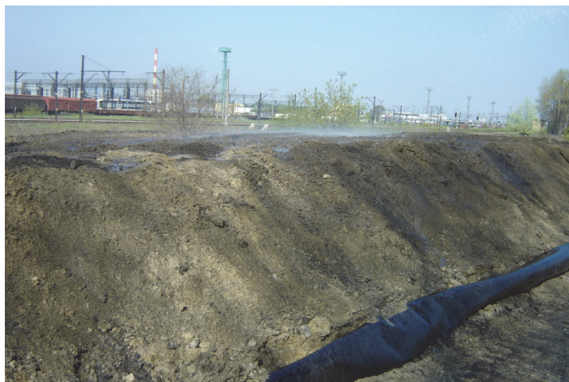
Rys. 8. Zraszanie skażonej gleby wodą z mikroorganizmami (Przygucki 2011)
