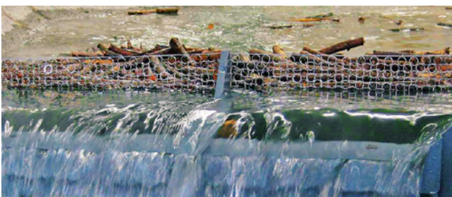
Najprostszy system przeciwrumowiskowy, schemat działania oraz zdjęcie obiektu w eksploatacji, źródło: Geobrug AG
