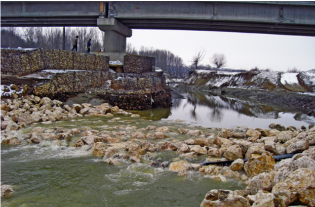
Widoczna elastyczna bariera stabilizująca dno koryta na odcinku posadowienia mostu
