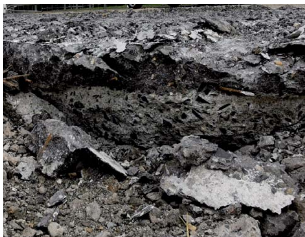
Fot. 3 i 4. Konstrukcja starej nawierzchni betonowej [2]
