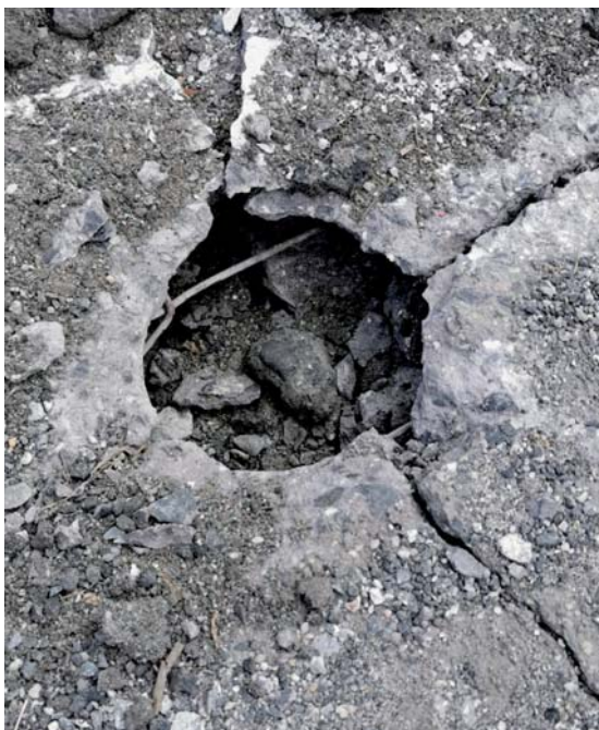
Fot. 1 i 2. Konstrukcja starej nawierzchni wraz z siatką stalową [7]
