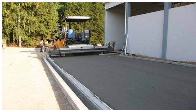
Fot. 3. Rozkładanie mieszanki betonowej na powierzchnię z betonu wałowanego
