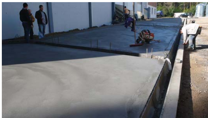
Fot. 2. Plac manewrowy wykonany z betonu wałowanego w miejscowości Rzeszyca
