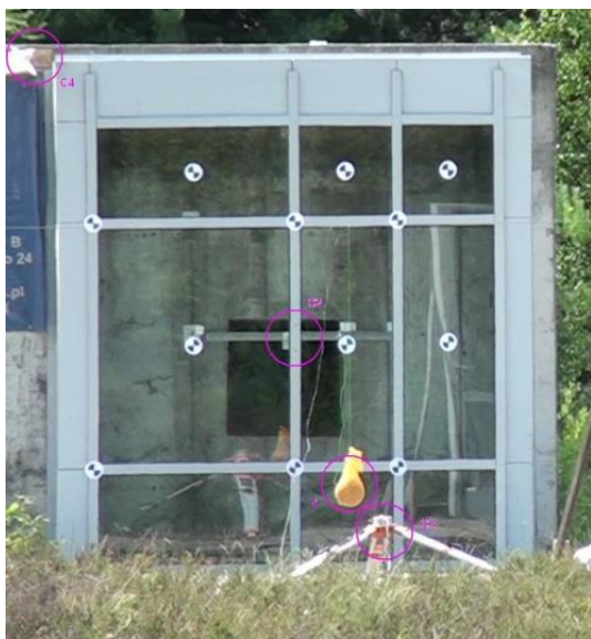
Fot. 2. Widok fasady z zaznaczonymi czujnikami i znacznikami
