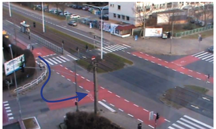
Fot. 8. Potencjalnie niebezpieczna trajektoria wjazdu na śluzę typu II w Gdańsku, ul. Bażyńskiego (fot. zbiory własne)
