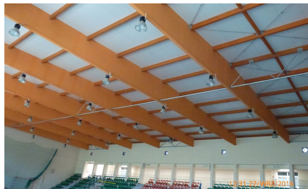
Fot. 1. Przekrycie hali sportowej – dźwigary i płatwie z drewna klejonego
