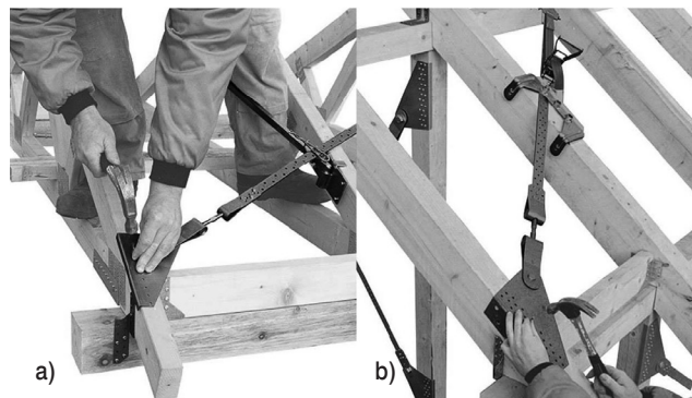
Fot. 6. Naciągarki ręczne (a) i ich zastosowanie przy napinaniu taśmy (b) [8]
