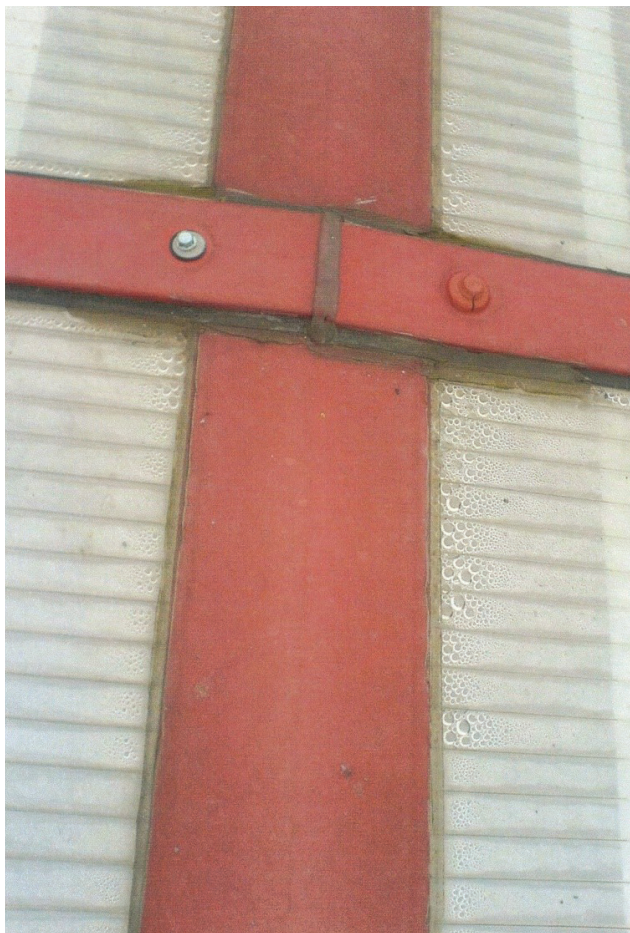
Fot. 5. Wykroplona para wodna pod czaszą świetlika
