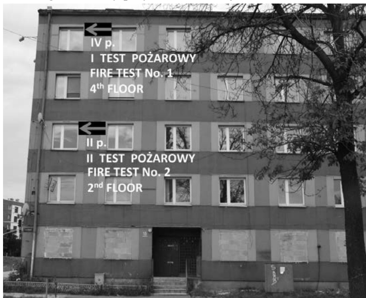
Ryc. 2. Widok budynku mieszkalnego przy ul. Pocztowej 15 w Bytomiu przewidzianego do testów pożarowych (przed etapem usunięcia płyt elewacyjnych zawierających azbest, lipiec 2012 r.)
