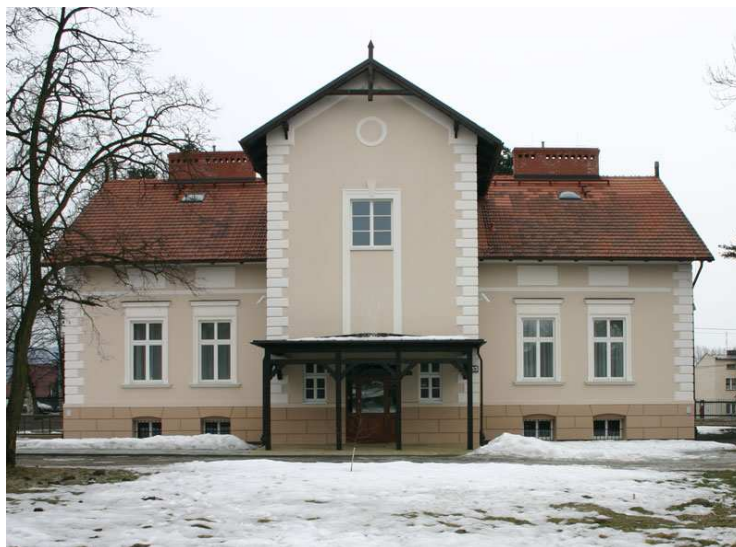
Rys. 1. Dworek w Mydlnikach – elewacja frontowa
