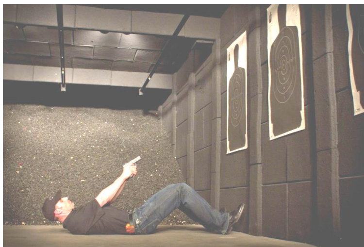
Fot. 1. Strzelanie do ściany będącej kulochwytem (w tle widoczny jest kulochwyty główny)[2]
