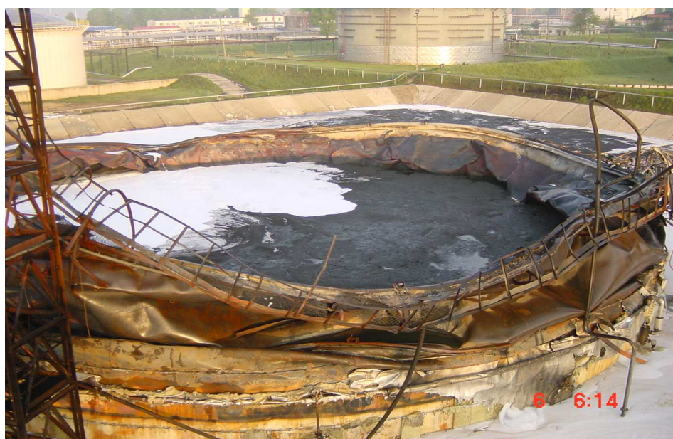
Ryc. 6. Zbiornik po pożarze w Rafinerii Trzebinia.
