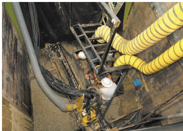
Rys. 6. Wnętrze wykopu początkowego z urządzeniem do przecisku w technologii Axis [13]
