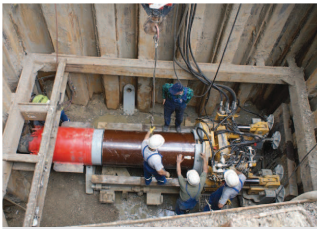
Rys. 5. Rozwiercanie gruntu za pomocą głowicy rozwiercającej z napędem bezpośrednim z jednoczesnym przeciskaniem hydraulicznym rur przeciskowych [14]
