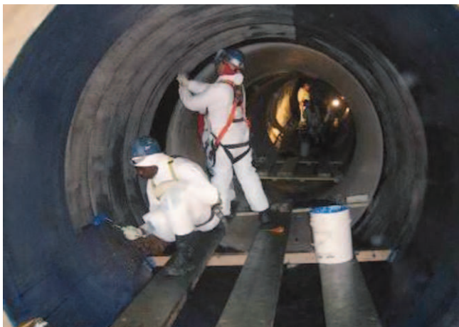
Rys. 3. Odnowa magistrali wodociągowej DN 2590 mm przy zastosowaniu tkanin węglowych doklejaných do wewnętrznej powłoki rur za pomocą żywicy [6]
