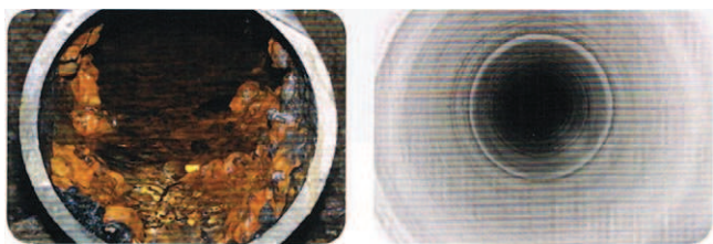
Rys. 4. Przewód wodociągowy z narostami inkrustacyjnymi przed rehabilitacją i po oczyszczeniu oraz wykonaniu natrysku jego wewnętrznej powierzchni żywicą polimocznikową [1]
