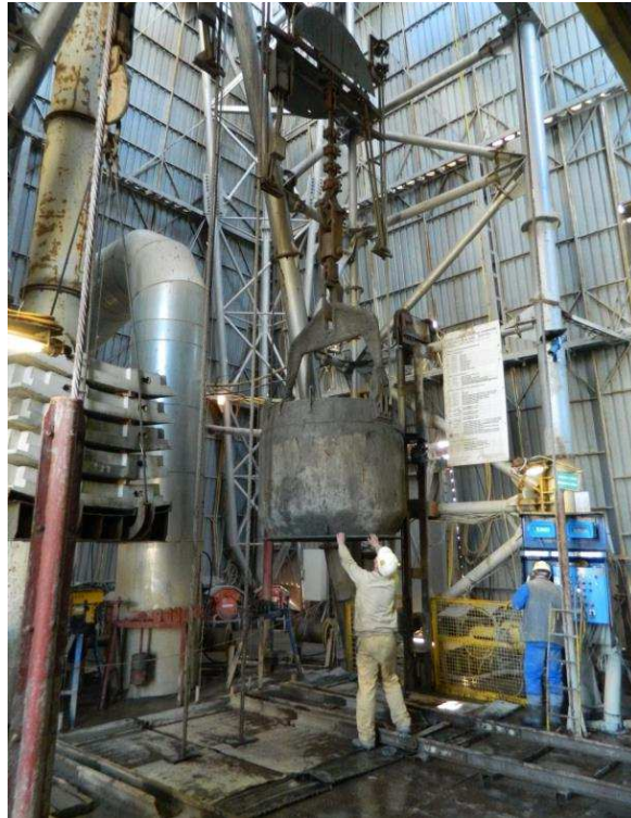
Rys. 2. Kubeł transportowy na zrębie szybu [5]
