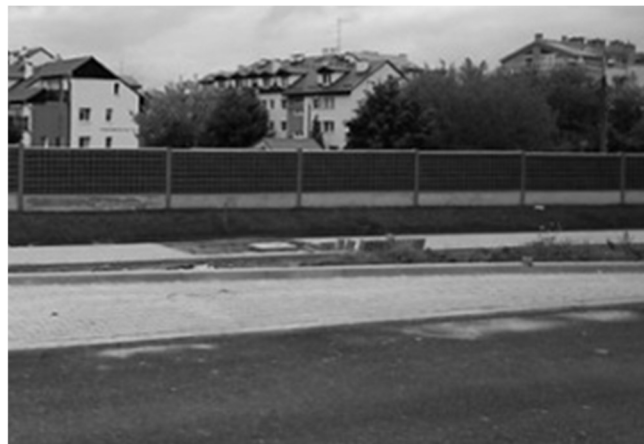
Rys. 4.5 Przykład zbyt niskiego ekranu akustycznego
