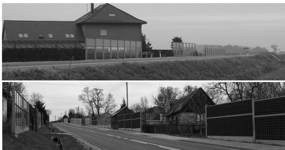
Rys. 4.10 Ekran akustyczny z licznymi przerwami zmniejszającymi ich skuteczność akustyczną
