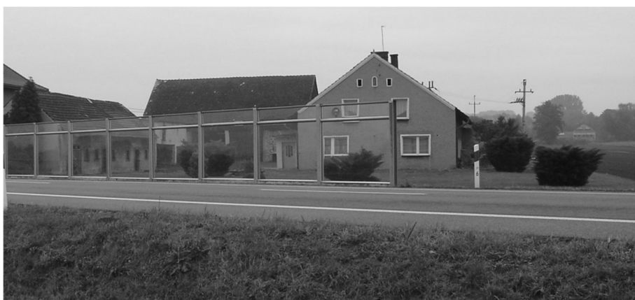
Rys. 4.3 Przykład zbyt krótkiego ekranu akustycznego
