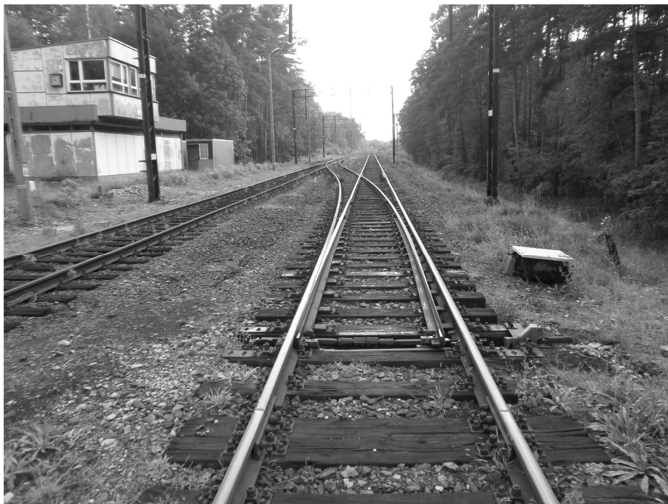
Rys. 2. Rozjazd zwyczajny nr 1 typu S60 – 1:9 – 300 (fotografia własna)
