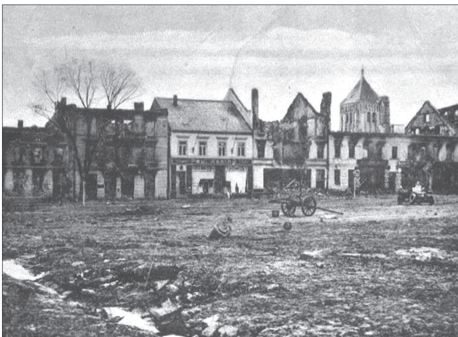
4. Stan zabudowy rynku w Gołdapi po zniszczeniach w czasie pierwszej wojny światowej. Źródło: fotopolska.eu 4. The condition of buildings in and around Gołdap's marketplace after the destruction during the First World War Source: fotopolska.eu
