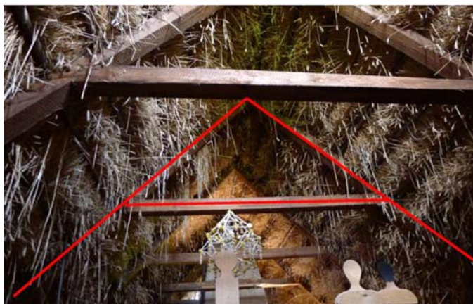
Ryc. 2. Więżba dachowa jętkowa chałupy z Rebowo (1875 r.)
