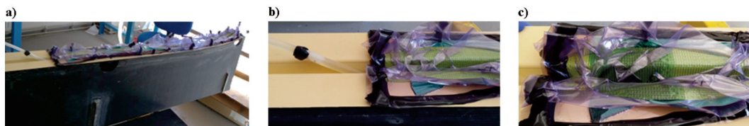
Rys. 9. Proces Infuzyjny krawędzi natarcia łopaty nośnej: a) widok ogólny, b) doprowadzenie żywicy, c) przesylenie zbrojenia [Autor, 2015]
