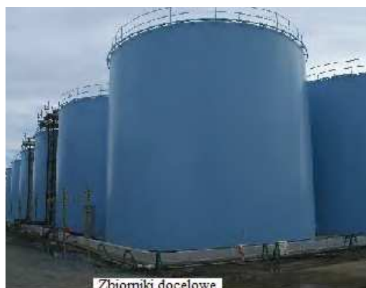
Rys. 2. Zbiorniki ścieków radioaktywnych (Fot. Ho/Reuters oraz referat A.Toby Seminarium Tepco Warszawa 19 Marzec 2014) Photo. 2. Radioactive waste tanks
