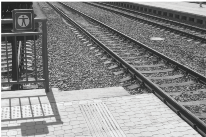
Fot. 2. Zabezpieczenie końca peronu (1)
