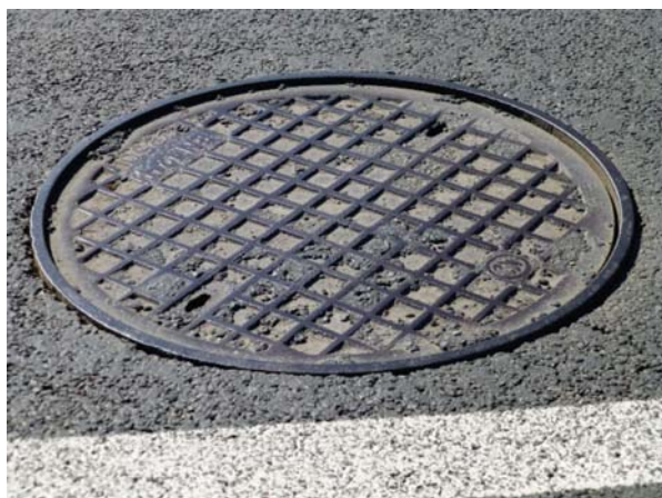
Fot. 1. Właz studni kanalizacyjnej w jezdni
