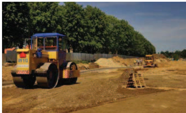
Rys. 3. Budowa układu drogowego
