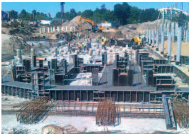
Rys. 4. Wykonywanie oczepów fundamentowych
