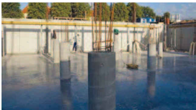
Rys. 5 i 6. Betonowanie dna niecki sportowej – technologia Leier-Panel
