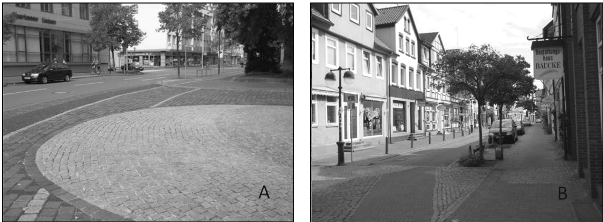
Fot. 3. Poziome odgięcia (Uelzen, Niemcy).
