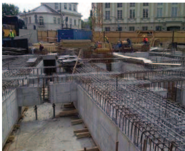
Rys. 4. Widok belek zabetonowanych do wysokości 1,2 m z przerwami poprzecznicami
