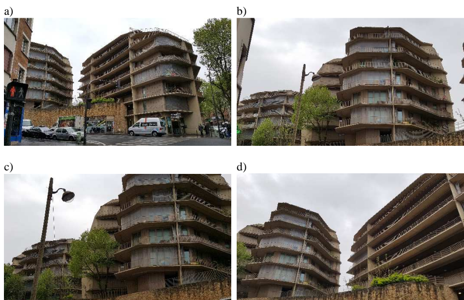
Fot. 4a,b,c,d. Budynek mieszkalny przy Le boulevard Sérurier. Fot. M. Krupa, 2017
