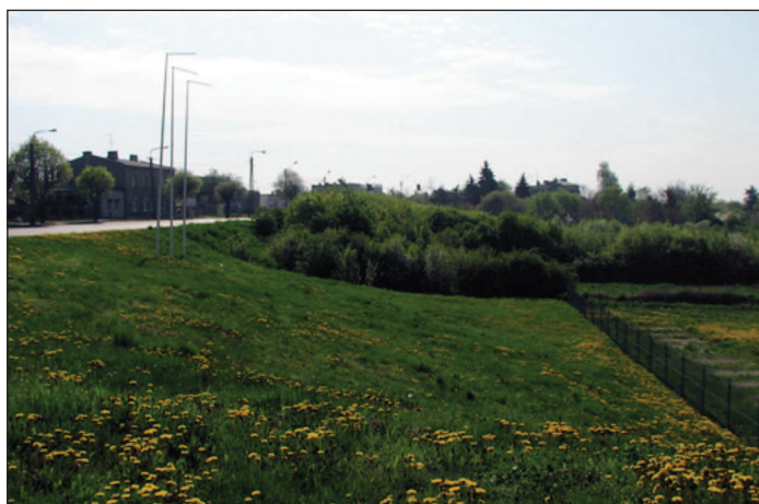
Fot. 1. Stroma skarpa wzdłuż ul. Łódzkiej w Kaliszu od strony południowej na wysokości odkrytego rowu, maj 2013, fot. Z. Małecki
