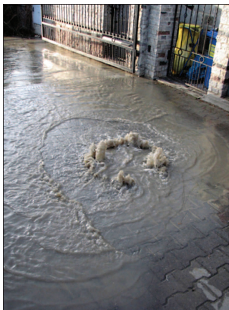
Fot. 7. Rozlewisko „wybijających” ścieków ze studzienki kanalizacyjnej na końcu ul. Spokojnej. Kalisz, 08.07.2009, fot. Z. Staszewski.
