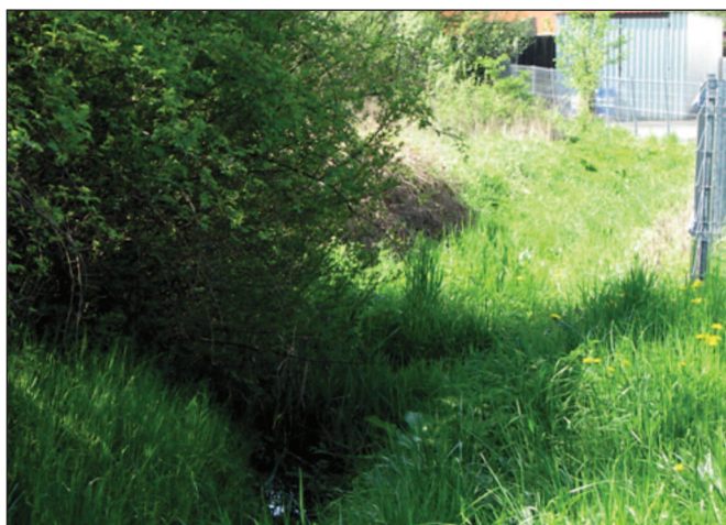
Fot. 3. Rów melioracyjny od strony południowej, maj 2013, fot. Z. Małecki
