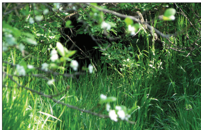
Fot. 2. Widoczny w głębi nieczynny kolektor deszczowy przechodzący pod ul. Łódzką w Kaliszu od strony południowej, maj 2013, fot. Z. Małecki
