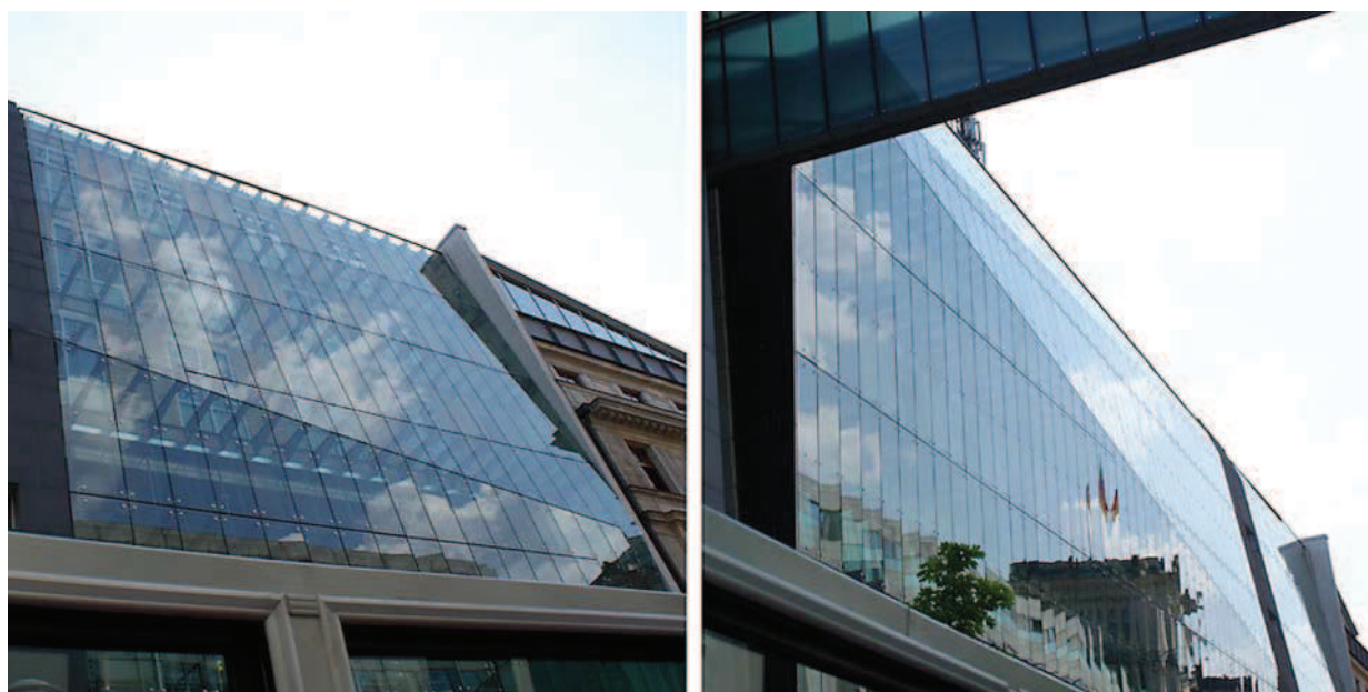
Ryc. 2. Budynek mieszkalny w Berlinie – dodatkowa warstwa szkła przy ruchliwej ulicy – widok w skali ulicy (fot. Ł. Wesółowski) Fig. 2. Residential building in Berlin – additional glass screen in a busy street – view in the scale of the street (photo by Ł. Wesółowski)
