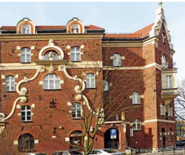
Kamienica „Pod Śpiewającą Żabą”, ul. Retoryka 1 – z nadbudowanym trzecim piętrem
