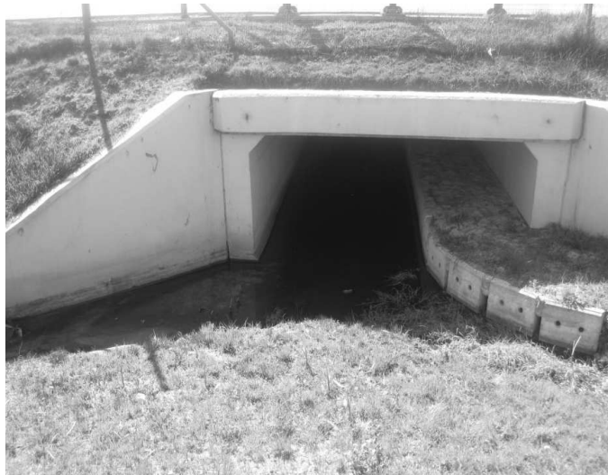
RYSUNEK 3. Przepust ekologiczne pełniący funkcję przejścia dla średnich zwierząt na odcinku Białobrzegi – Jedlińsk
