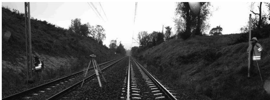
Rys. 7. Precyzyjna niwelacja geometryczna odcinka doświadczalnego toru kolejowego
