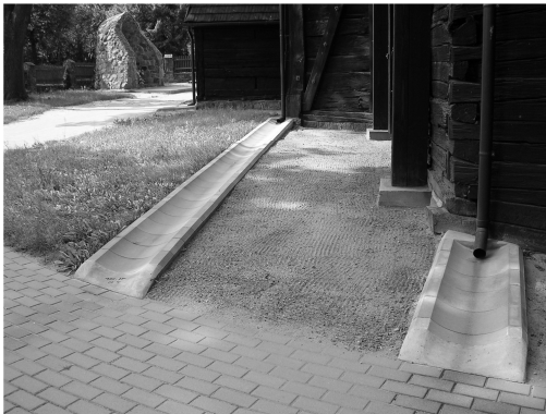
Fot. 3. Współczesna nawierzchnia i betonowe koryta wokół drewnianego kościoła we wsi Magnuszewice w powiecie jarocińskim.
