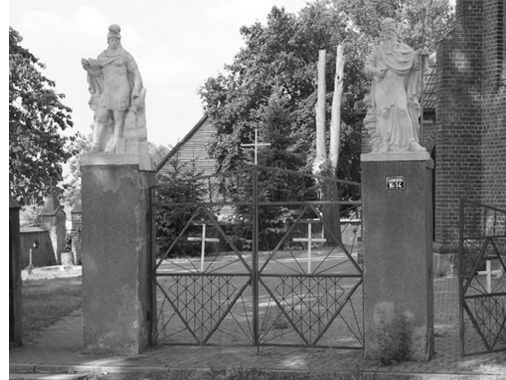
Fot. 2. Współczesne metalowe skrzydła osadzone w zabytkowej bramie kościelnej we wsi Radawnica w powiecie złotowskim (fot. A. Targońska, 2006).
