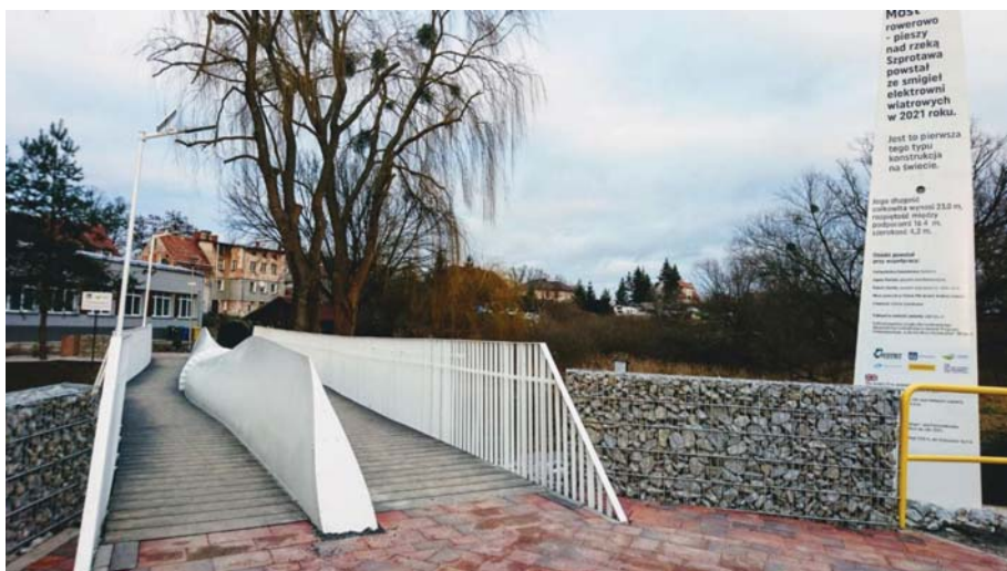
Rys. 12. Kładka w Szprotawie: a) widok ogólny z boku; b) widok wzdłuż pomostu
