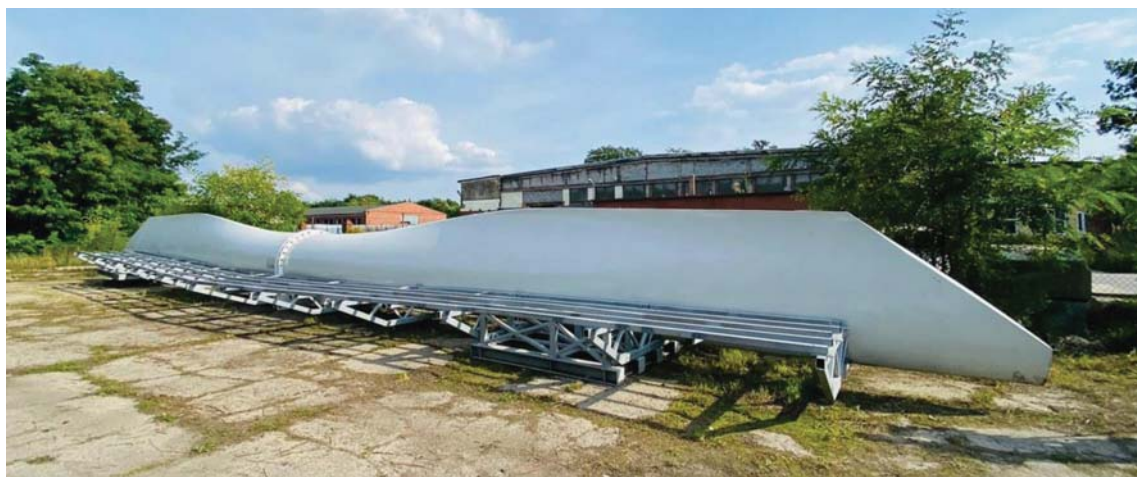
Rys. 8. Próbnny montaż przęsła kładki
