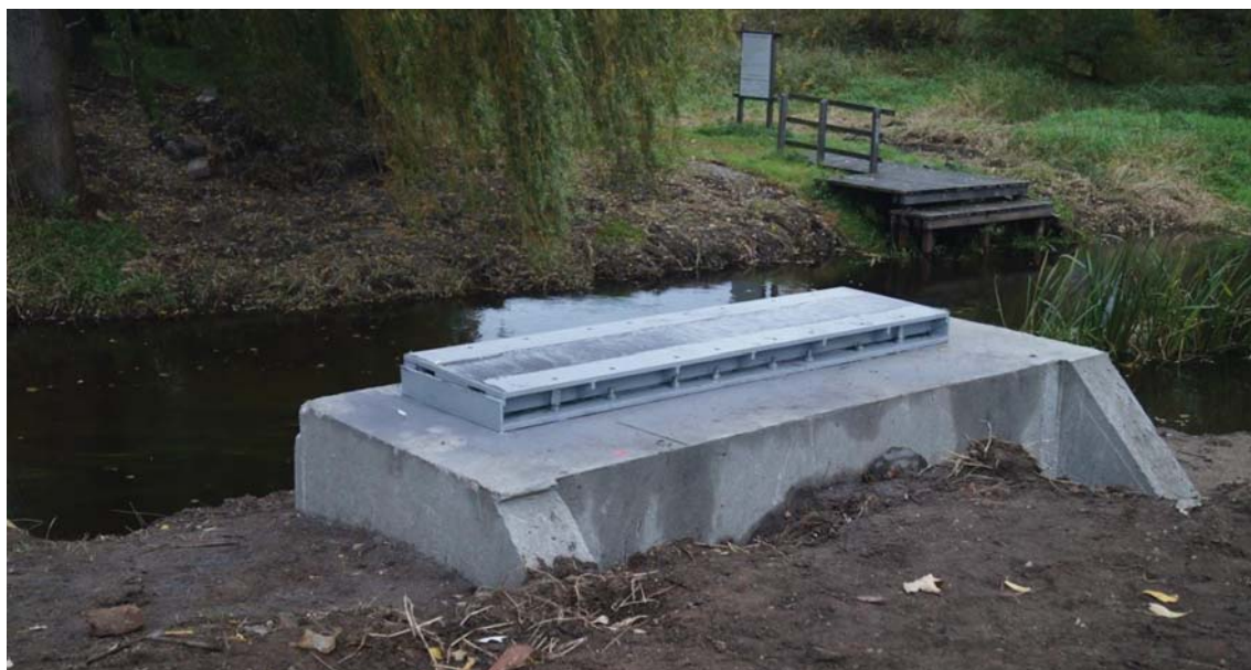
Rys. 8. Próbnny montaż przęsła kładki
