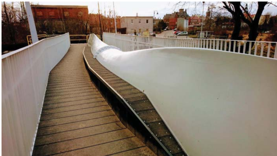
Rys. 11. Kładka z pełnym wyposażeniem
