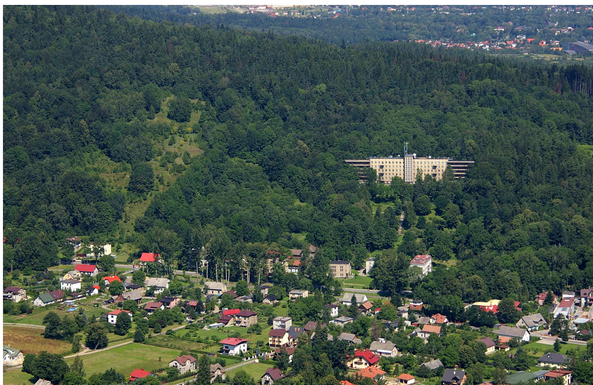
Fot. 4. Sanatorium w Bystrzej. Źródło: archiwum Urzędu Gminy Wilkowice. Photo 4. Sanatorium in Bystra. Source: Municipal Office Wilkowice archive.
