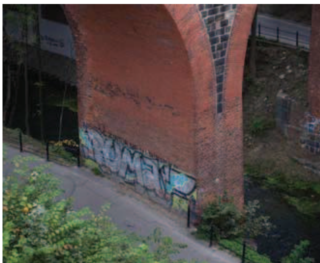
Rys. 6. Ceglany filar z kamienną pachą
