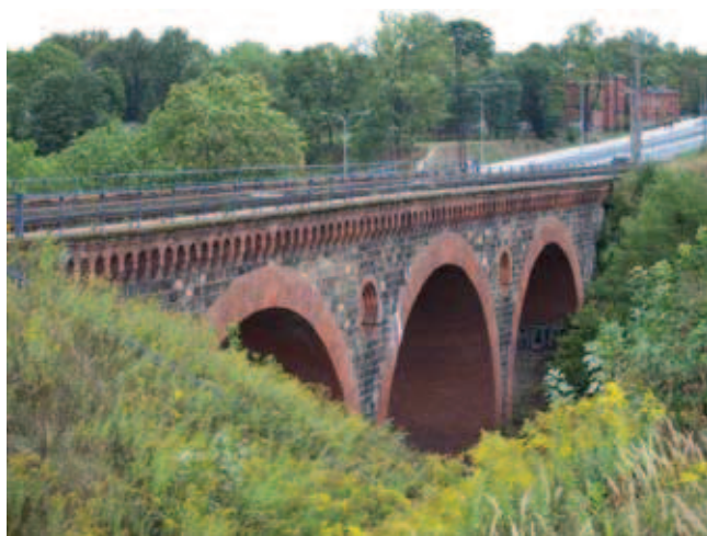
Rys. 1. Zabytkowy wiadukt o konstrukcji ceglano-kamiennej wzniesiony w 1872 roku w Olsztynie
