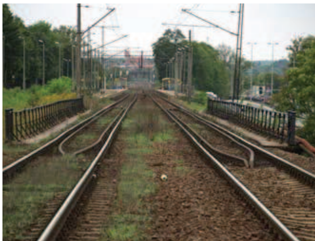
Rys. 4. Widok torowiska wiaduktu
