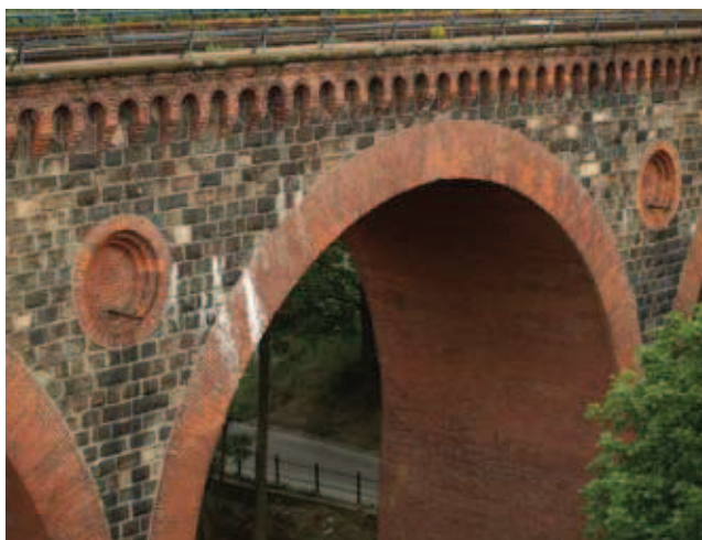
Rys. 5. Ceglane łuki i filary przęsła zdobione rozetą
