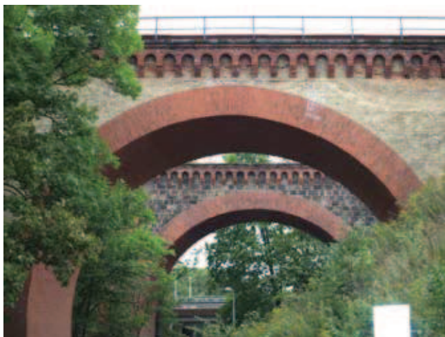
Rys. 3. Na pierwszym planie omawiany wiadukt (północny) posiada bliźniaczy obiekt – wiadukt południowy wzniesiony w 1892–1893 r.
