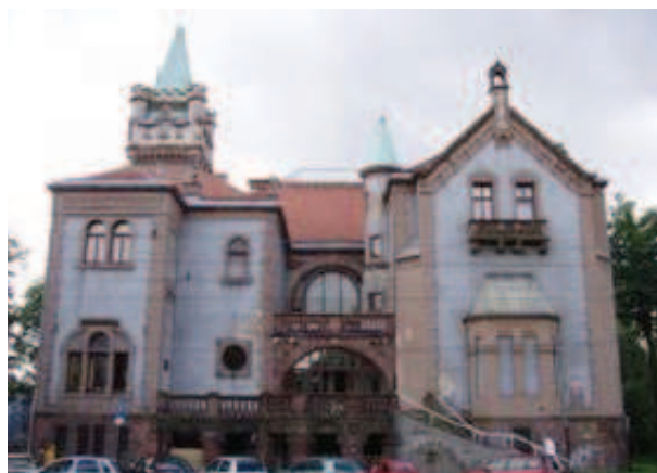
Rys. 3. Widok elewacji północnej Fig. 3. North facade
