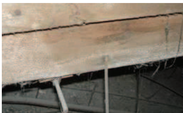
Rys. 6. Podwieszenie sklepień do belek stropowych Fig. 6. Suspension of the vault on the floor beam
