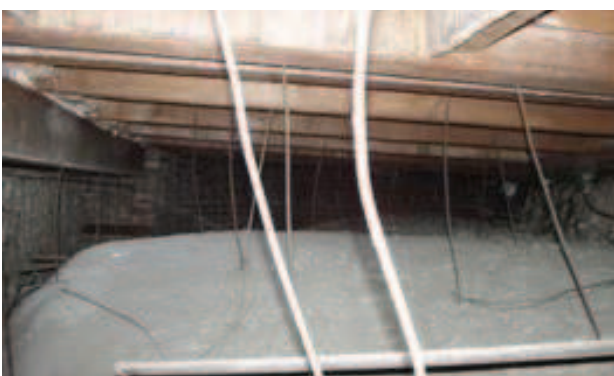
Rys. 6. Podwieszenie sklepień do belek stropowych Fig. 6. Suspension of the vault on the floor beam
