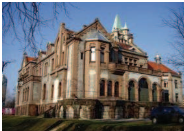
Rys. 2. Widok elewacji południowo-zachodniej Fig. 2. View of the North-West side
