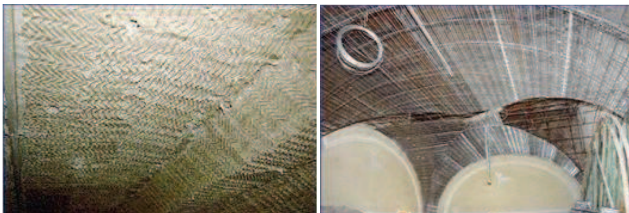
Rys. 1. Zastosowania siatek „Rabitz” [2] Fig. 1. Adaptation of the Rabitz mesh [2]
