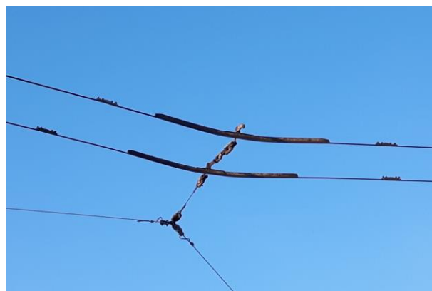
Rys. 9. Mocowanie przewodów sieci trakcyjnej na łuku starego typu, fotografia: Michał Krawczyk
