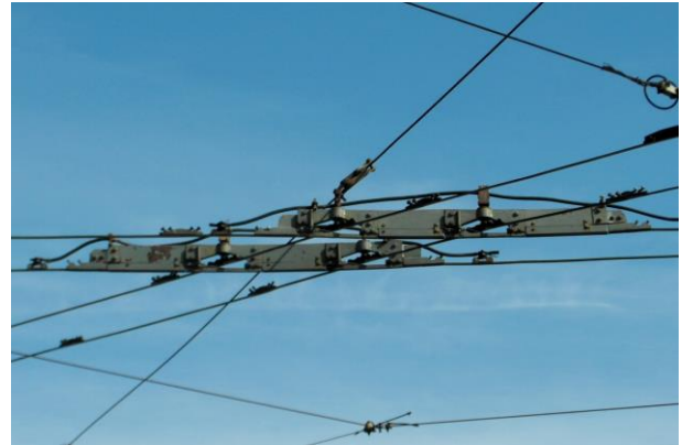
Rys. 12. Krzyżownica sieci trakcyjnej, fotografia: Michał Krawczyk
