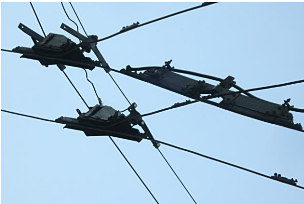
Rys. 11. Zwrotnica sterowana prądowo, fotografia: Michał Krawczyk
