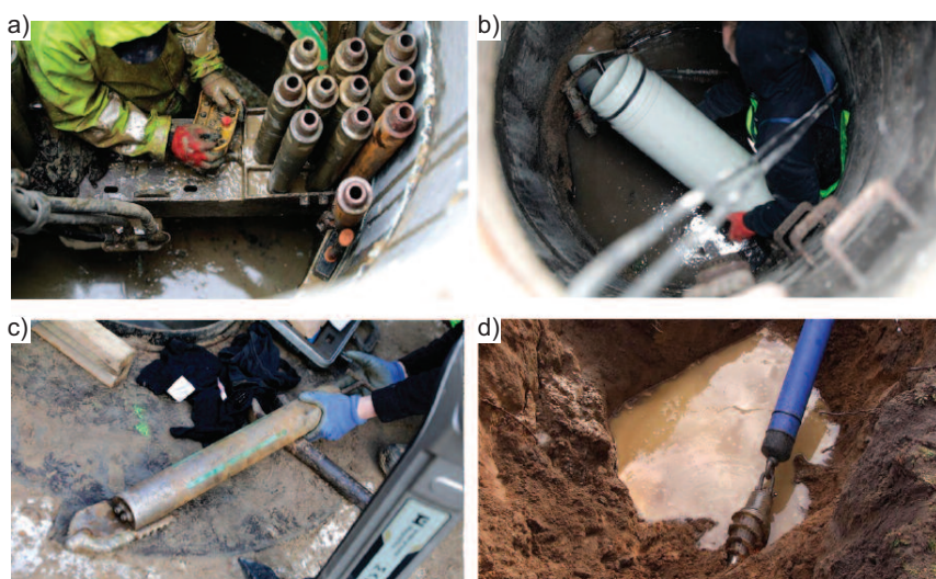
Fot. 2. Przewiert poziomy realizowany między studzienkami kanalizacyjnymi zestawem polskiej produkcji [8]: a) przewiert pilotowy – maszyna rozparta na wymaganym poziomie w studzience, widoczne żerdzie pilotowe; b) wprowadzanie (wciąganie) modułów rurowych PP przez rozwierconą ściankę studzienki za cofanymi żerdziami pilotowymi i poszerzaczem; c) głowica pilotowa (tu w wariantcie ze wspomaganiem wiercenia płuczką wiertniczą); d) poszerzacz (w wariantcie wciągania z wykopu zgrzewanej rury PE)
