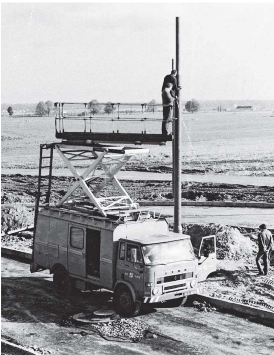
Ryc. 2. Pogotowie sieci Star 28 SWN 11, nr tab. 535. Budowa sieci trakcyjnej na ul. Hubalczyków. (Fot. Miroslaw Lisowski, ze zbiorów Piotra Proniuka)
