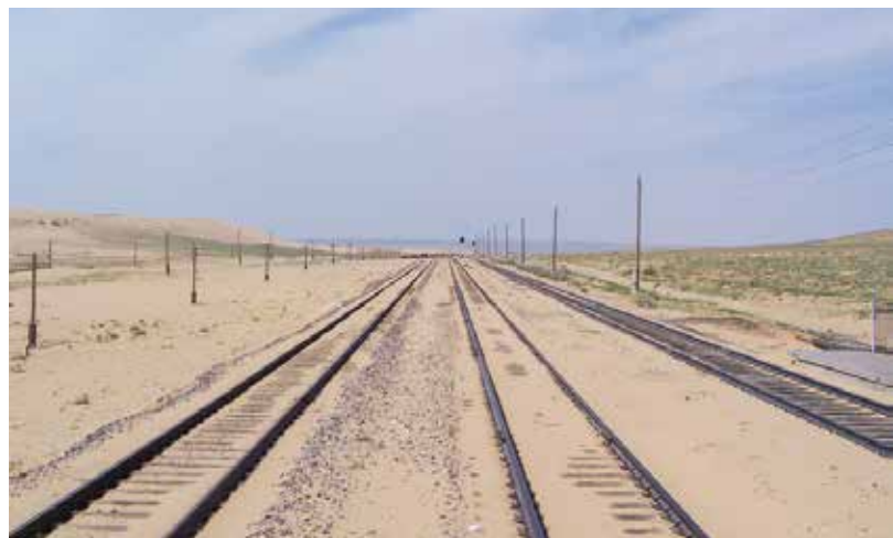
Stacja Cagan chad na linii Sajszand – Zamyn Uud (3.07.2007 r.)
