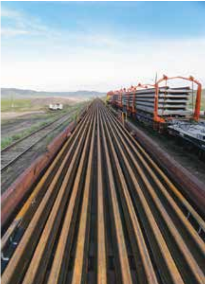
Nowe szyny na platformie kolejowej na stacji Mandat (24.07.2009 r.)
