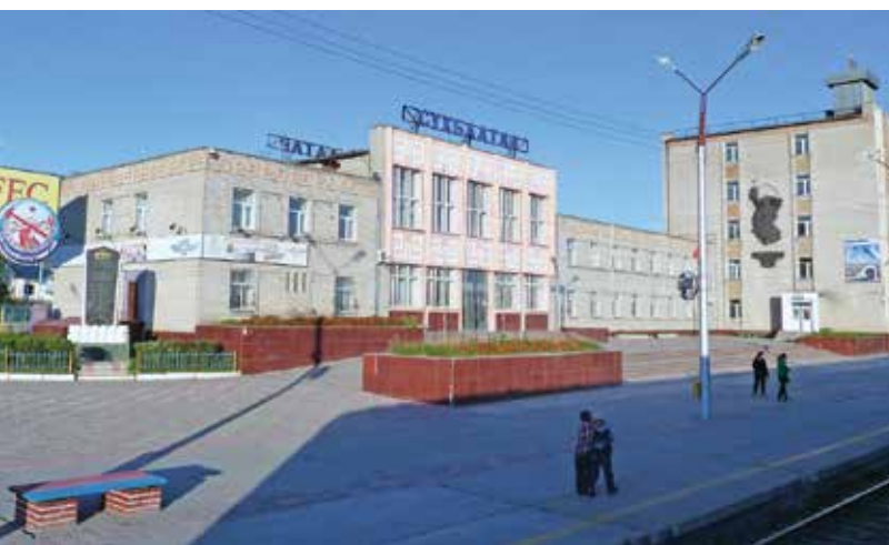
Stacja Such Bator (4.09.2011 r.) fot. P. A. Leclercq / Wikimedia Commons
