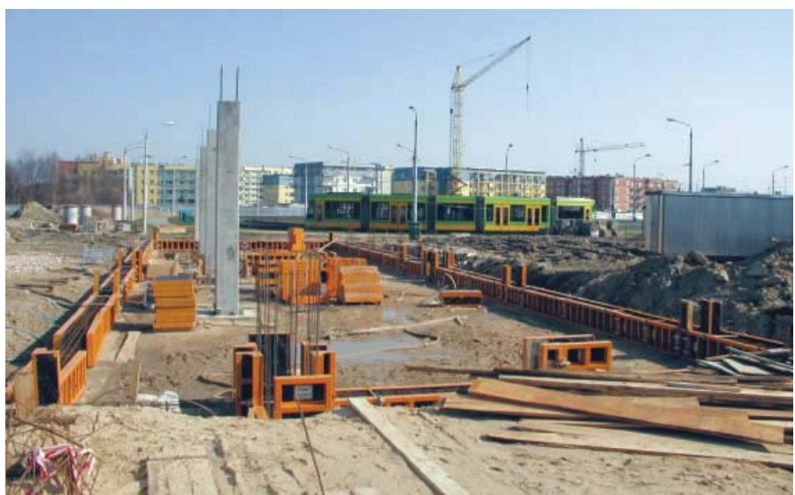
Fundamenty i betonowe słupy podtrzymujące dach stanowisk odjazdowych
