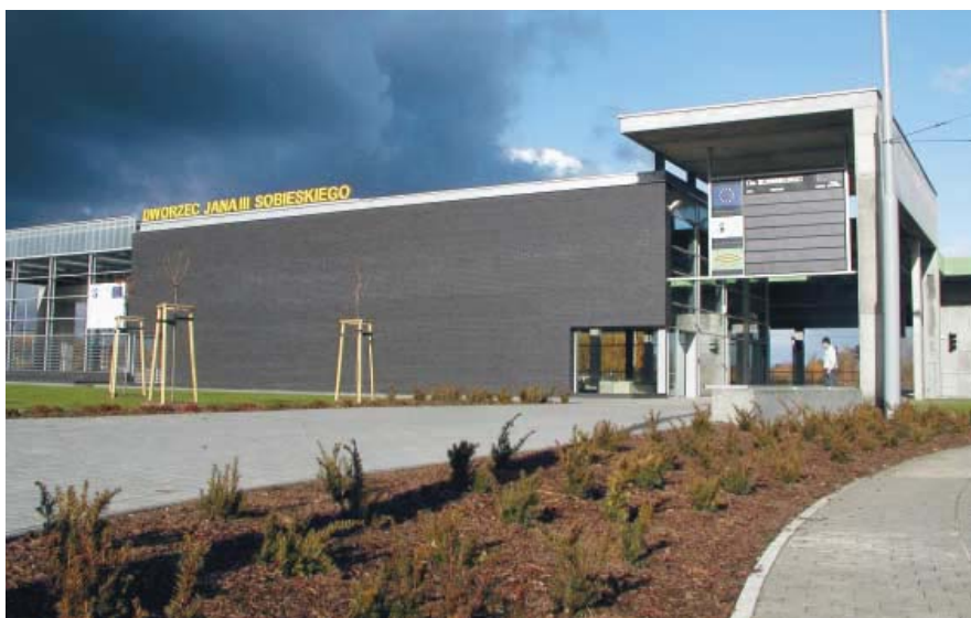
Głównym elementem dworca jest ściana z czarnej klinkierowej cegły
