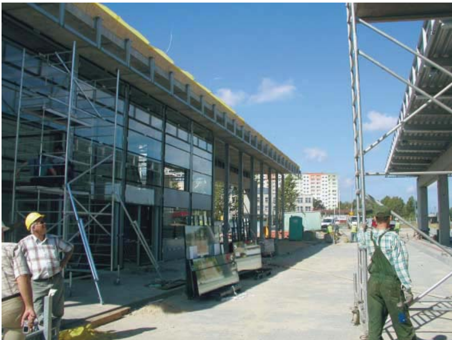
Budowa hali dworcowej
