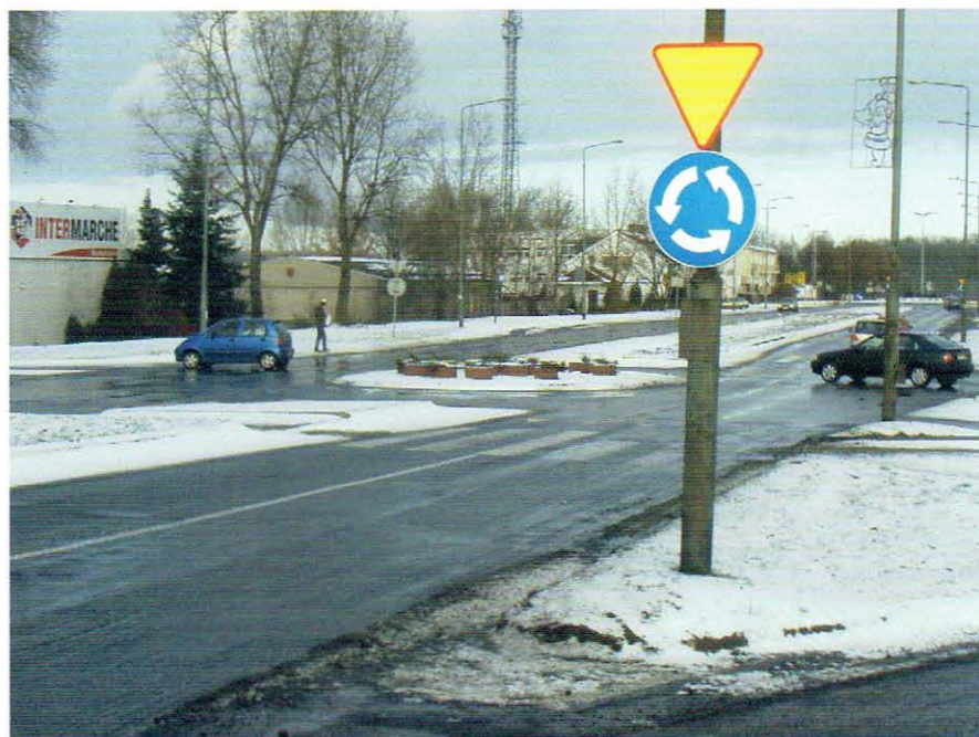
Rys. 4. Skrzyżowanie o ruchu okrężnym w Koninie na ul. Kleczewskiej
