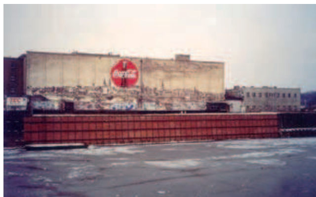
Rys. 7. Widok muru nabrzeża naprawionego w 2002 roku
