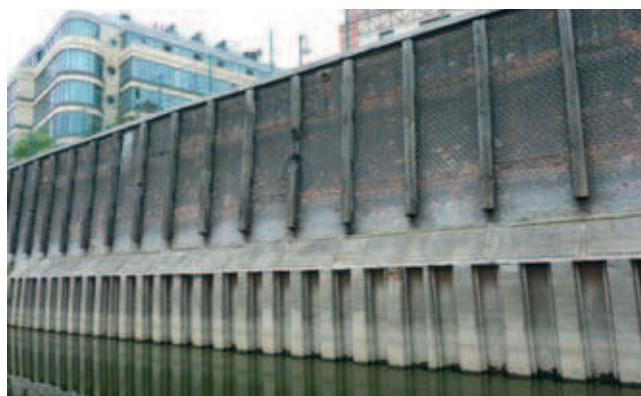
Rys. 5. Fragment muru zabezpieczonego w dolnej części ścianką Larssena
