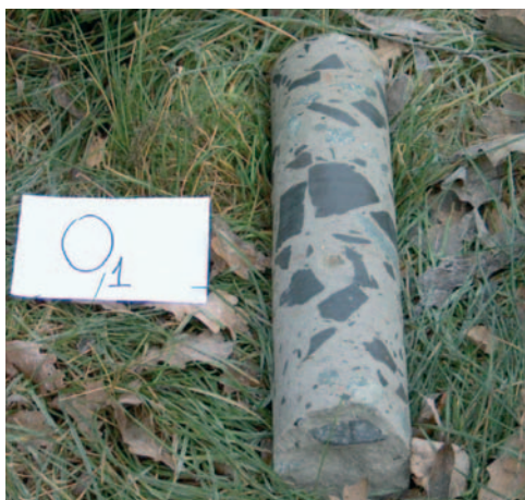
Fot. 5. Przykładowy widok odwiertu, pobranego z filara mostowego (widoczne pojedyncze duże ziarna kruszywa bazaltowego i granitowego)
