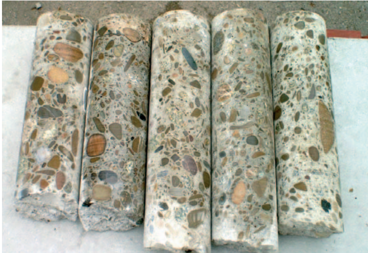
Fot. 1. Widok grupy odwiertów rdzeniowych, pobranych z konstrukcji belki ustroju niosącego mostu przez rzekę Dunajec w miejscowości Złobice
