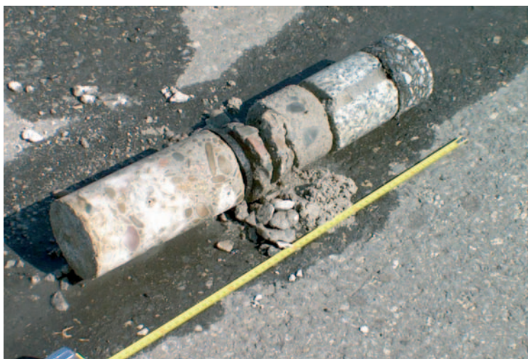
Fot. 4. Przykład wykorzystania odwiertu do ustalenia układu warstw w przekroju jezdni
