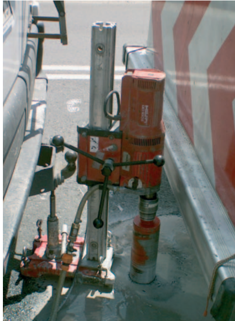
Fot. 3. Widok wiertnicy w czasie wycinania odwiertu z mostowej płyty pomocowej
