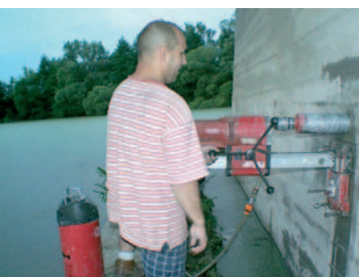
Fot. 2. Widok wiertnicy w czasie pobierania odwiertu rdzeniowego z filara mostowego
