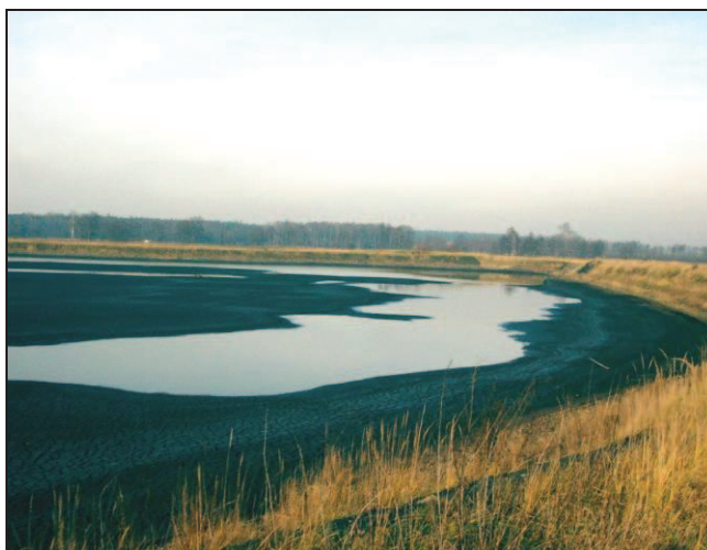
Fot. 1. Zbiornik „Bojszowy” od strony południowej
