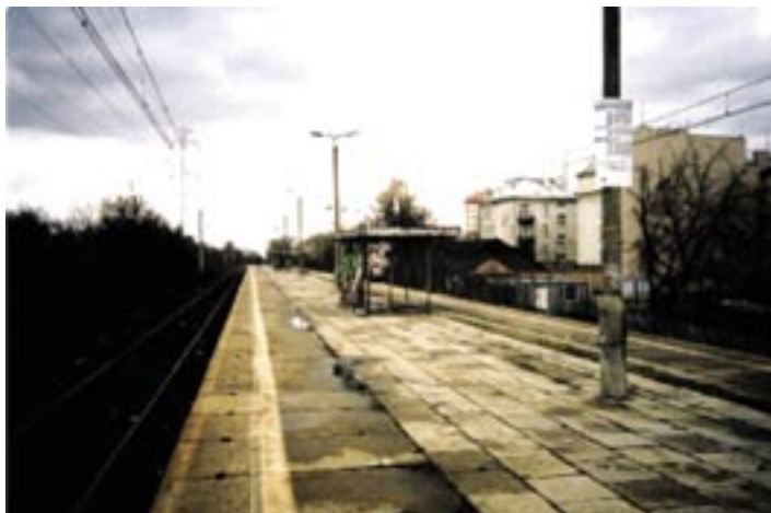
Przystanek Warszawa Kasprzaka
