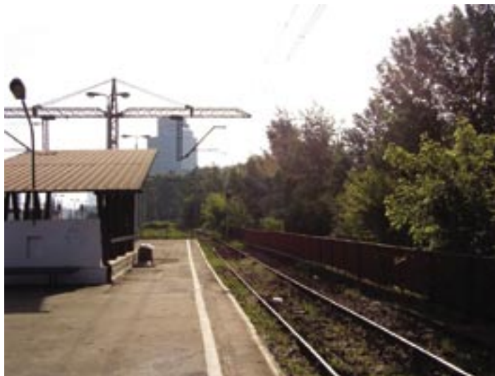
Warszawa Zachodnia WKD wraz z fragmentem miejsca pod przyszłą pętlę tramwajową
