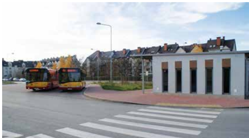
Nowa pętla autobusowa przy ul. Massalskiego [6]
