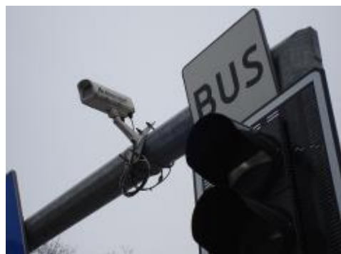
Zdj. 1. Elementy systemu sygnalizacji świetlnej z wjazdem priorytetowym dla komunikacji miejskiej (Radom). (źr. wł.)
