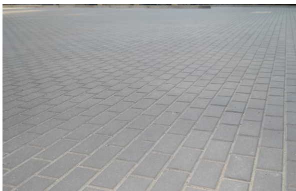
Rys. 2. Widok nawierzchni odcinka badawczego.
