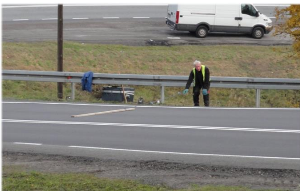
Rys. 2.5. Lokalizacja przeszkody na jezdni asfaltowej.
